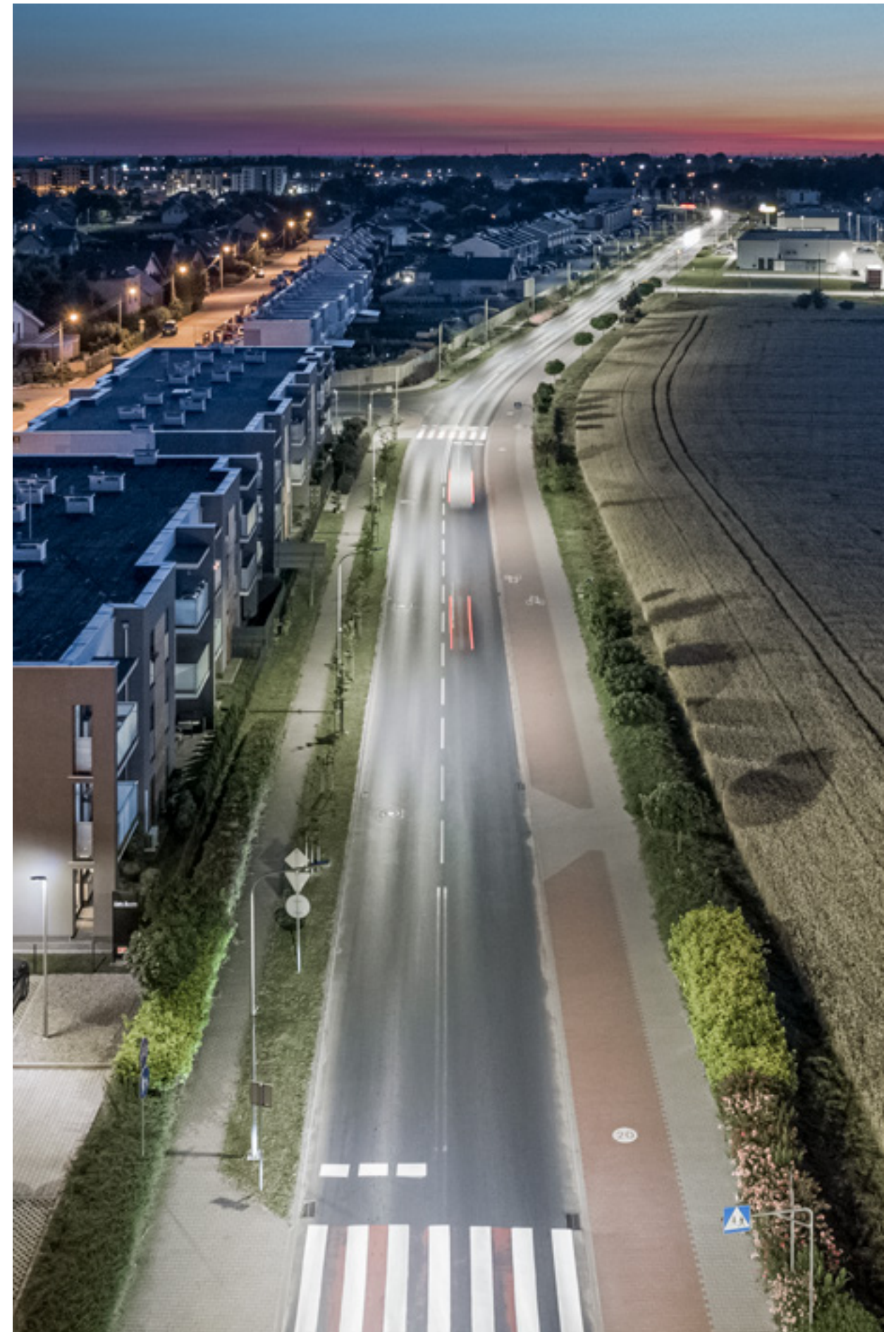
Oświetlenie drogowe w Środzie Wielkopolskiej
